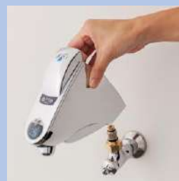
③センサー上部をかぶせ、締付
