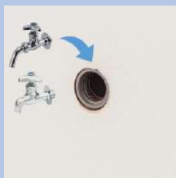
①既設水栓を取り外す
